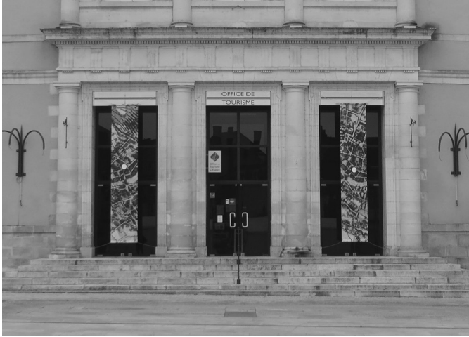
Fig. 14. Façade de l'ancien tribunal pendant l'installation.
