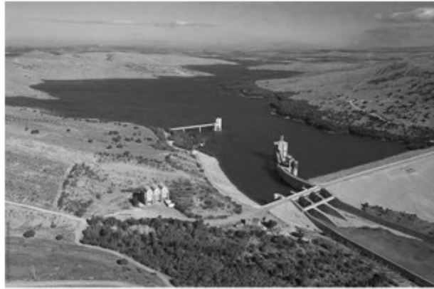
Figure 8 : Le barrage de Sīdī Sālim
