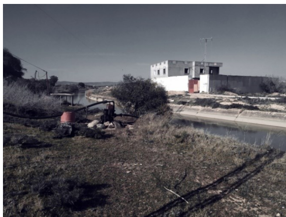
Figure 11 : Pompage « illicite » au diesel situé au niveau du « Grand canal »
