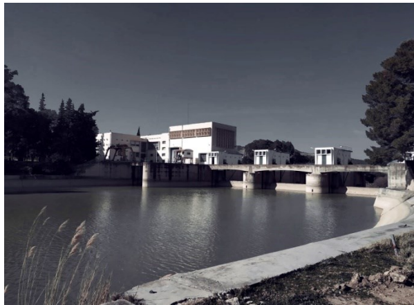
Figure 9 : Le barrage d' al-'Arūsiyya
