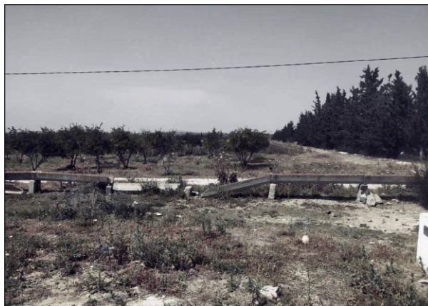
Figure 17 : Ancien réseau d'irrigation à ciel ouvert endommagé, gouvernorat de la Manouba
