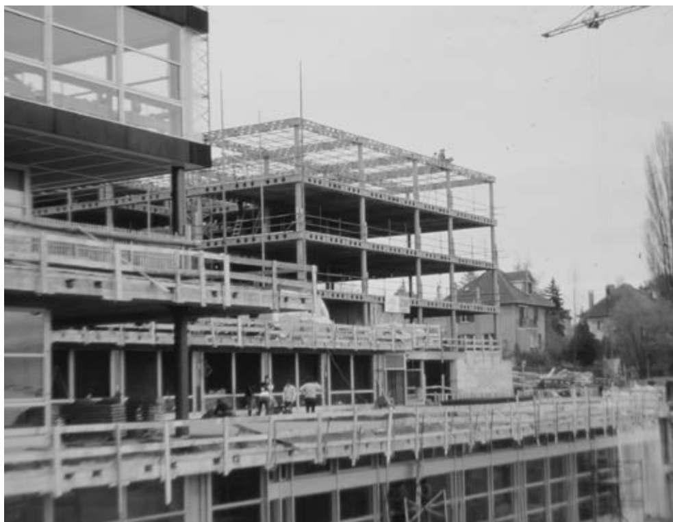
Fig. 2 : B. Vouga, M. Lévy, architectes, Groupe scolaire des Bergières, Lausanne, 1968-1975, chantier. Archives Ville de Lausanne, Lausanne.
