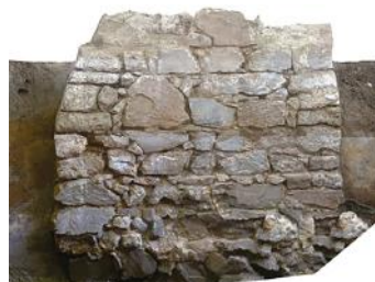
Fondation d'un pilier d'angle du grenier sur les flancs de la terrasse et de la berge (CRAN).
