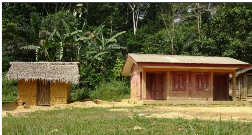
Figure 3. À droite, un logement construit dans le cadre du projet et à gauche, un logement construit par la suite et habité par une famille Baka
