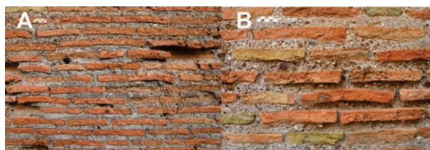
Fig. 7 – Caseggiato dei Molini (I, III, 1), détails de la maçonnerie – A : mur nord de la pièce 22, B : mur est de la pièce 8 (photographies de l'auteur).
