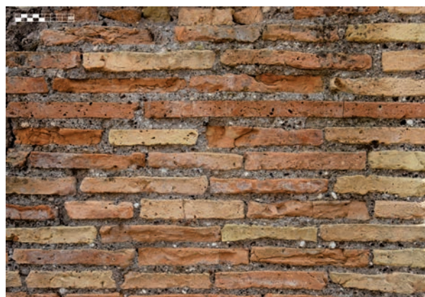
Fig. 25 – Caseggiato V, VI, 2, détail de la maçonnerie d'un des piliers sur la Via dei Serpenti (photographie de l'auteur).
