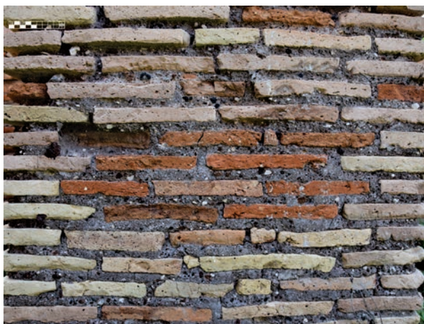
Fig. 23 – Caseggiato dell'Ercole (IV, II, 2-3), détail de la maçonnerie du pilier au centre de la pièce 14 (photographie de l'auteur).
