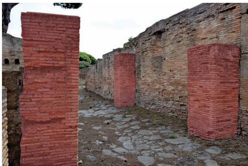
Fig. 24 – Via dei Serpenti, vue depuis le sud avec piliers de soutènement (photographie et élaboration de l'auteur).
