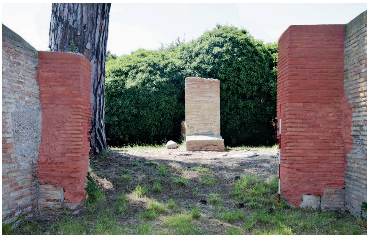
Fig. 10 – Caseggiato delle Taberne Finestrata (IV, V, 18), entrée de la pièce (Y) vue de l'intérieur et reconstruction de la façade (photographie et élaboration de l'auteur).
