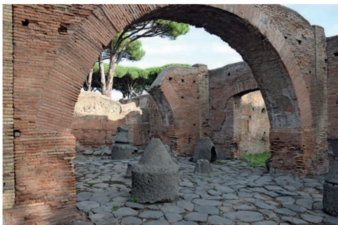
Fig. 3 - Caseggiato dei Molini (I, III, 1), vue depuis le sud des pièces 19-20-21 (photographie de l'auteur).
