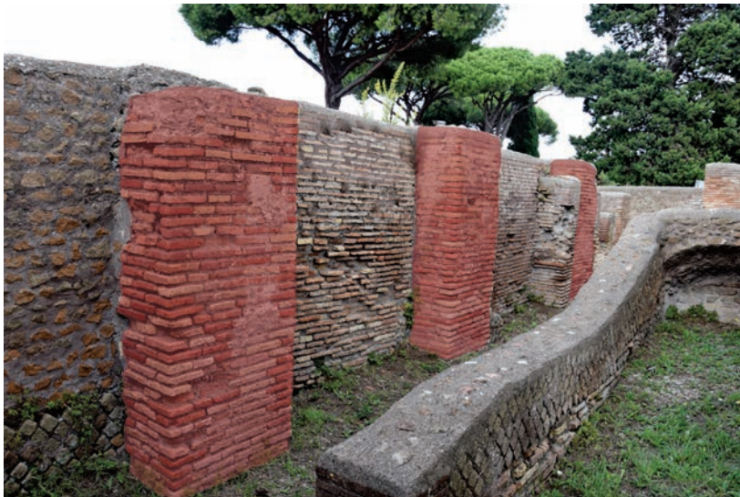
Fig. 16 – Caseggiato del vicolo del Dioniso (IV, V, 7), cage d'escalier ouest, piliers de soutènement (photographie et élaboration de l'auteur).
