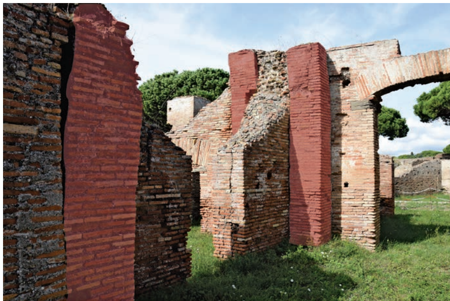
Fig. 19 – Casoggiato dell'Ercole (IV, II, 2-3), vue de la pièce 11 avec piliers de soutènement (photographie et élaboration de l'auteur).
