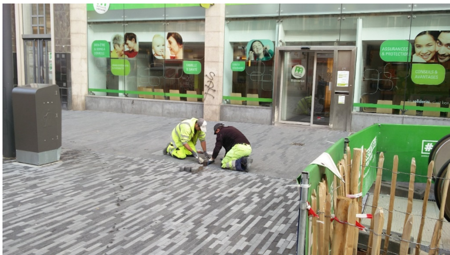
Fig.6 : Réfections en cours sur le piétonnier.
