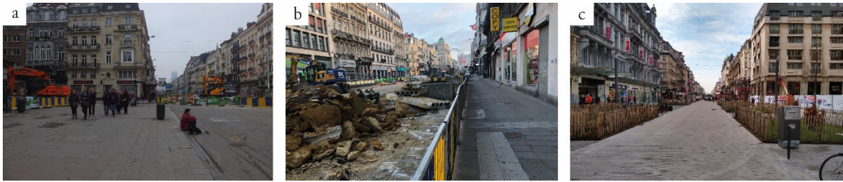
Fig.4 : Les trois états du piétonnier (a : phase transitoire ; b : pendant les travaux ; c : après l'aménagement).
