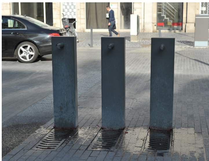
Fig.32 : Fontaine à eau potable du piétonnier.
