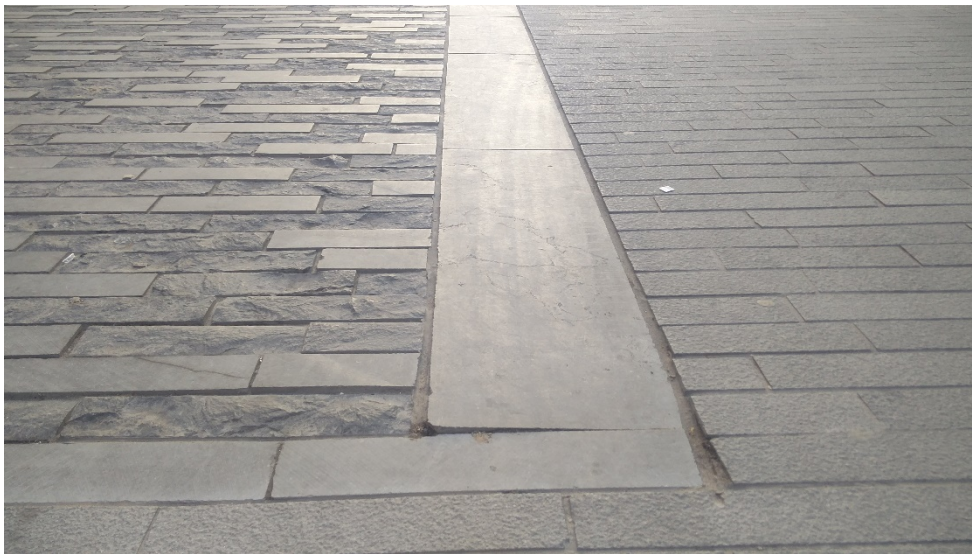
Fig.22 : Revêtement du piétonnier (dalles au relief prononcé à gauche ; dalles 'classiques' à droite).
