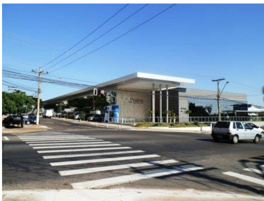
Fig.32 – Siège de Videira , après la rénovation du hangar, dans le Setor Bueno , Goiânia. Photo de l'auteur.
