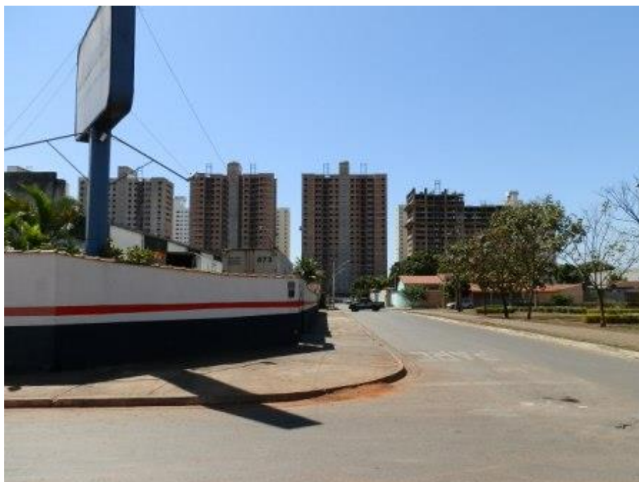
Fig.12 – Condomínio fechado vertical en voie de construction au milieu d’un quartier populaire aux maisons basses. Goiânia, Setor Cândida de Moraes . Photo de l’auteur.
