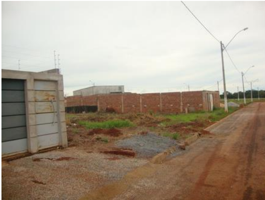
Fig.15 – Maisons en construction entourées de murs dans un nouveau quartier parcellé. Goiânia. Source : quebarato.com.br .
