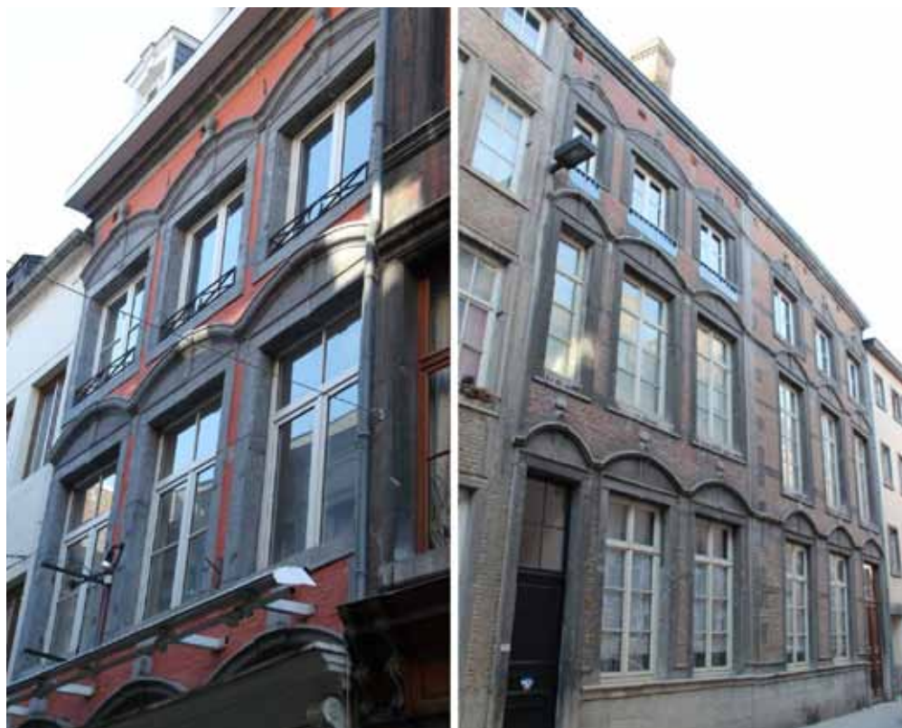
Fig. 10. Namur, Façade rue Fossés Fleuris n°4-6 , 1696.
