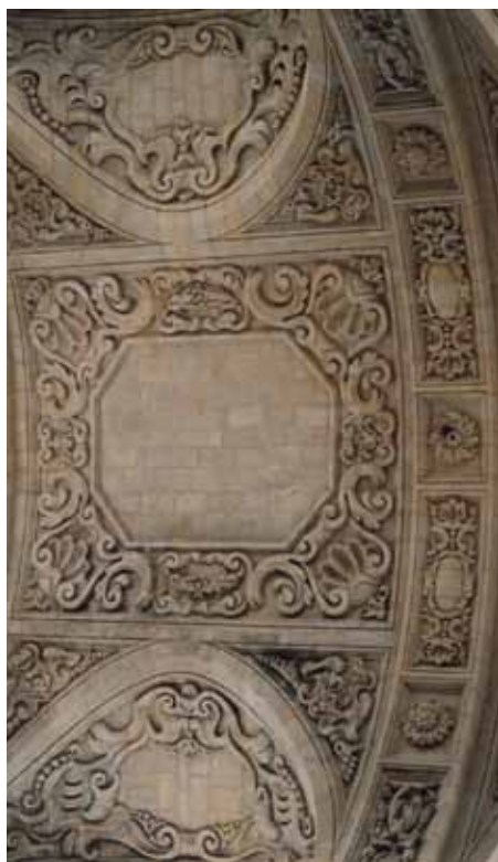
Fig. 3. Pierre HUYSENS, Namur, Eglise Saint-Loup : voûte de la nef : première travée, 1638-1643. Cliché C. Heering.
