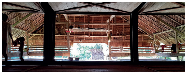
Fig. 8. — Vue sur la laibok (première pièce) d'une uma (maison collective), localité de Butui. Crédit photo : L. Simon, 2019.
