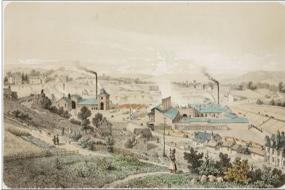
Zn smelting plant, Angleur, Liège, 1855
