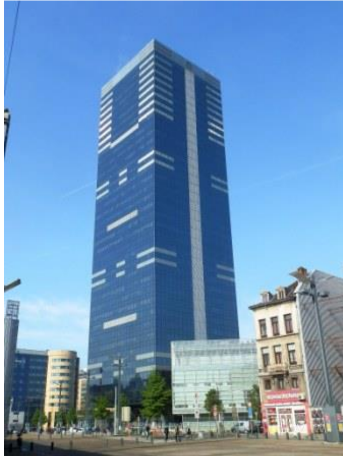
Fig.97 – La « Tour du Midi » avec son annexe à la base, fidèlement repris pour la vision CEF (fig.99). Comme son nom l'indique, cette tour se trouve à côté de la Gare du Midi (visible sur la gauche). Etant la plus haute tour de Bruxelles, elle est une balise importante dans le paysage urbain et un des repères principaux des migrants brésiliens à Bruxelles. Photo de l'auteur.
