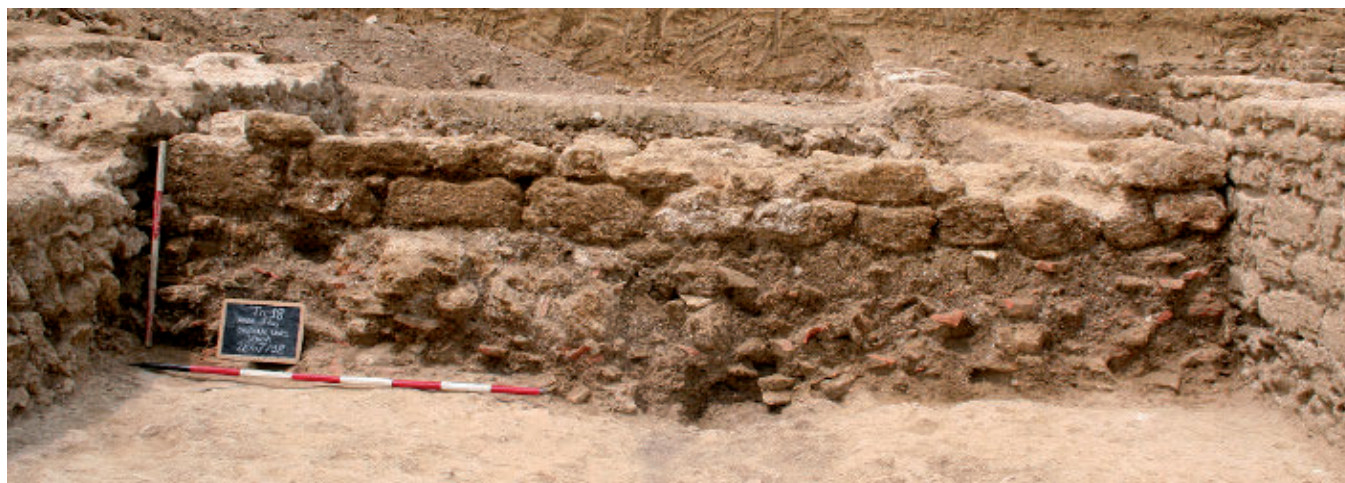
FIG. 62. Vano K. Muro ( cloison ) in bozze di riutilizzo, USM 9709 (foto S. Lenzi, 2018).
