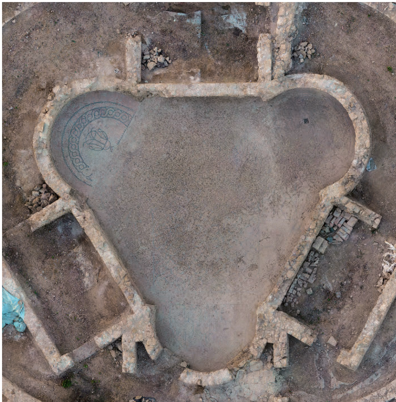
FIG. 47. Foto zenitale della Sala triabsidata dopo gli interventi di restauro sul cementizio dell'abside NO (foto B. Guillaume, © UCLouvain, 2017).
