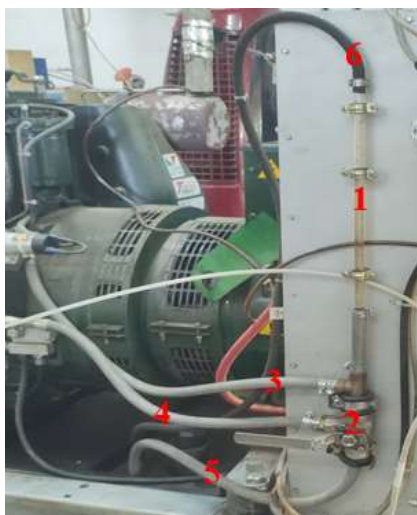
Figure III. 3 : Système de mesure du débit du diesel
