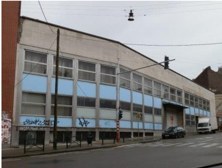
Fig.78 – Bâtiment rue Picard à Molenbeek-Saint-Jean, utilisé par l’ Eglise de Dieu de Belgique et qui héberge également Kairos Ministry , l’église de la pastora Ircemes . Photo de l’auteure.
