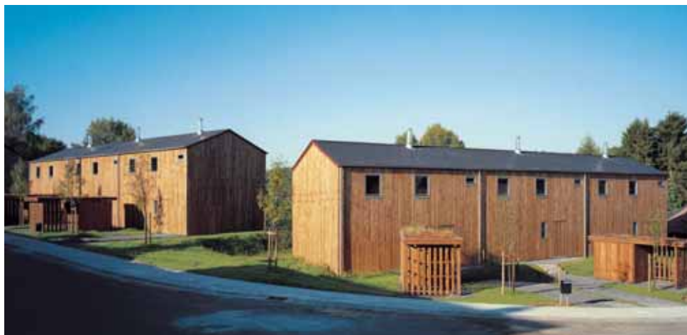
Logement / Auteur du projet : Dethier & associés, Liège Photo : www.sergebrison.com
