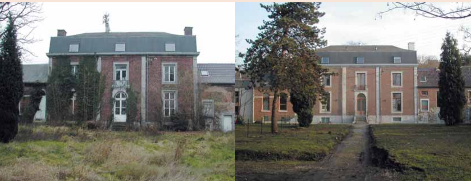
Façade arrière avant/ après © FLW
