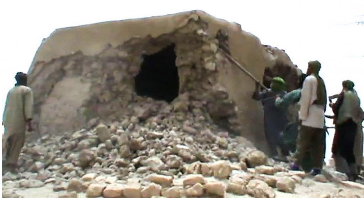
Photo 24: Mausolées après destruction
