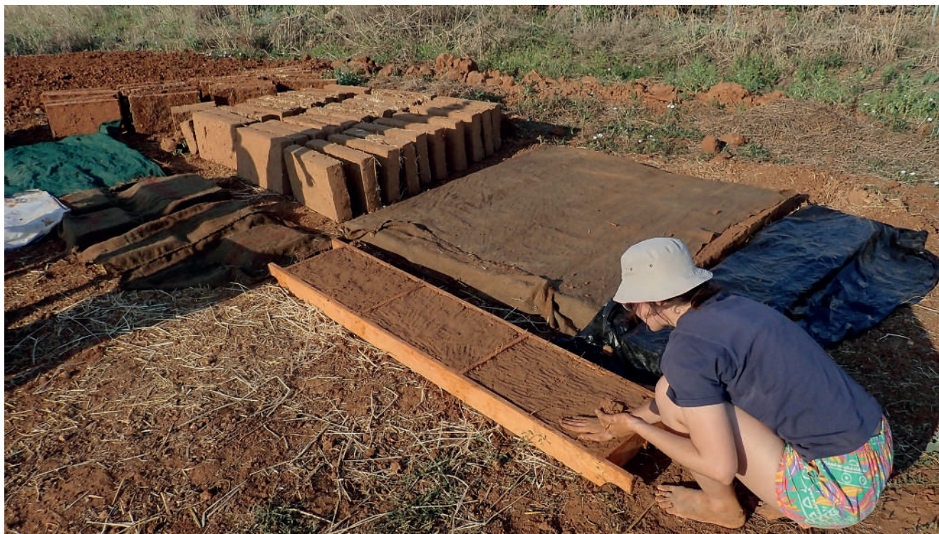
Fig. 3. Moulage des briques expérimentales dans un moule triple en bois (M. Pomadère).
