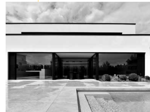
■ Plateau en décrochage et marche des escaliers accueillent de subtiles sources de lumière quand les colonnes en miroirs réfléchissent la blondeur de la pierre. (CFA Architectes)
