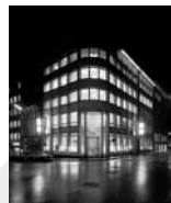
MODERNISME [ CIAL ] Rue Aldringen, Luxembourg
