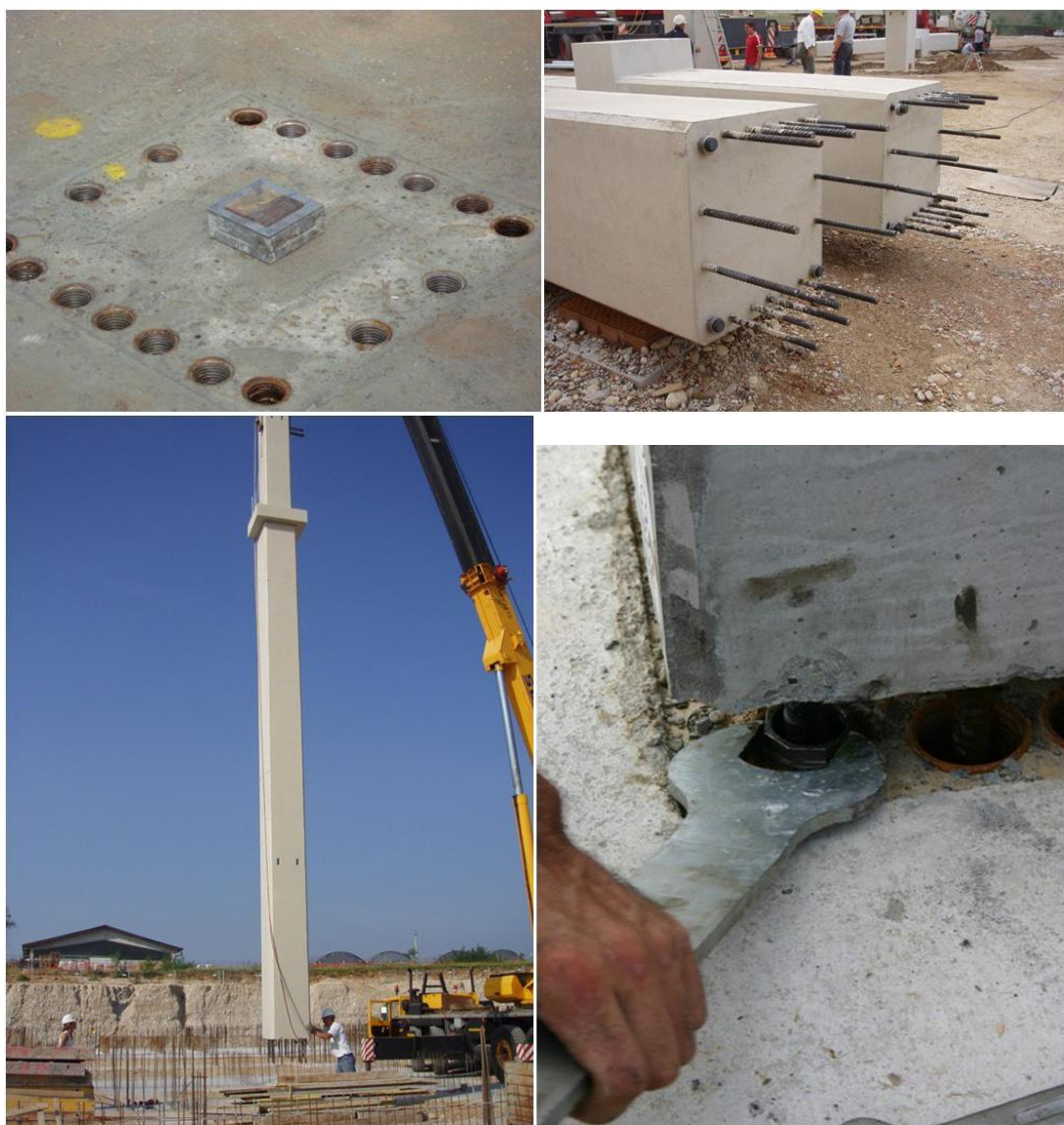
Figura 2. Immagini che evidenziano la facilità della posa in opera di una colonna.
