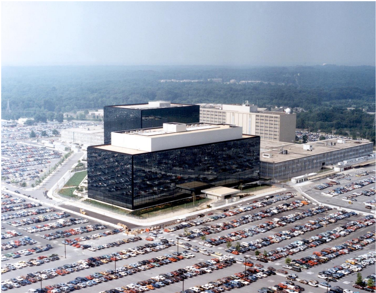
Figure 22 : Fort Meade, quartier général de la NSA
