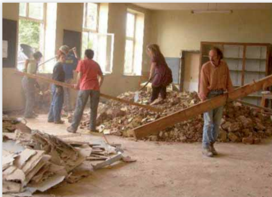
Solidarité pour les travaux de rénovation
