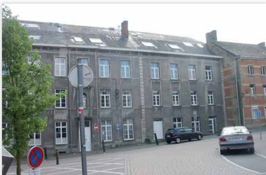
La Tarlatane à Lille : projet d'autopromotion avec réhabilitation d'une ancienne école
