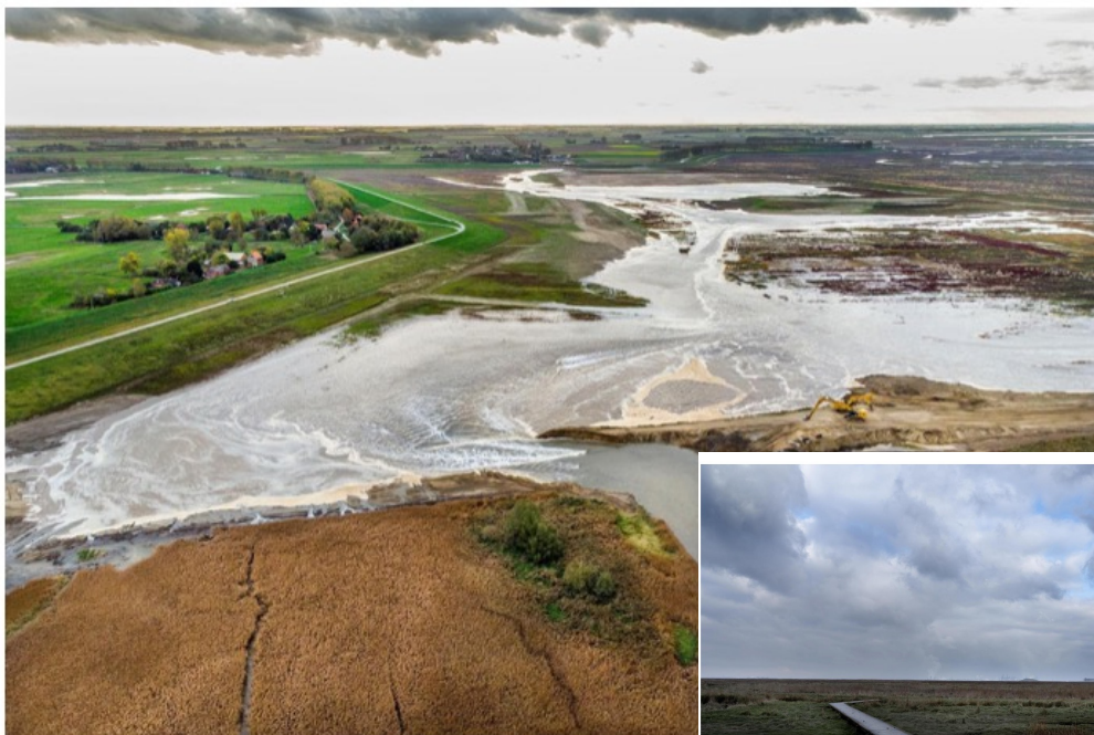
Graafmachines laten opnieuw water in de polders stromen. Arie Kievit © Arie Kievit
