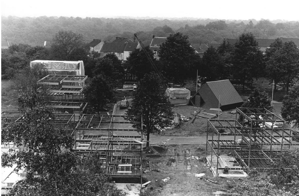
Figure 1 Ossatures du Sart Saint-Nicolas en cours de construction, 1978. (Archives Paul Petit)
