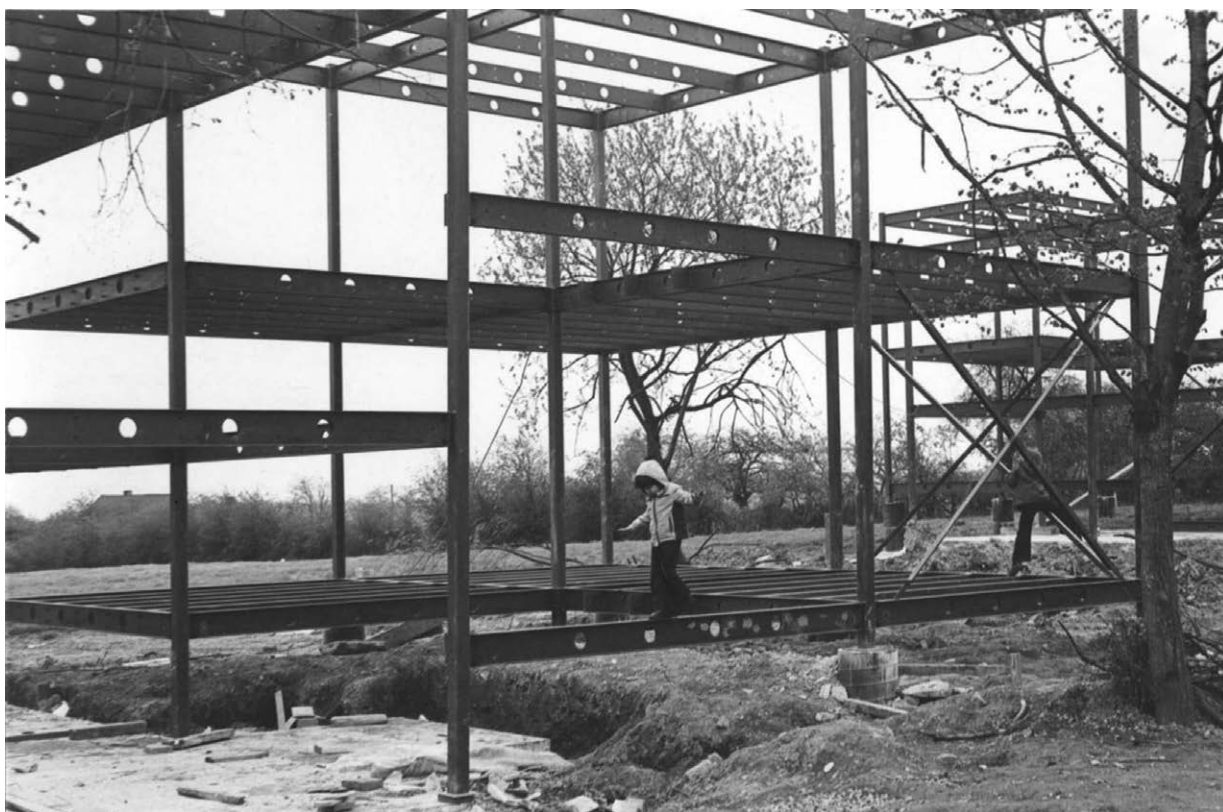
Figure 2 Chantier d'une maison métallique au Sart Saint-Nicolas, vers 1976. (Archives Paul Petit)
