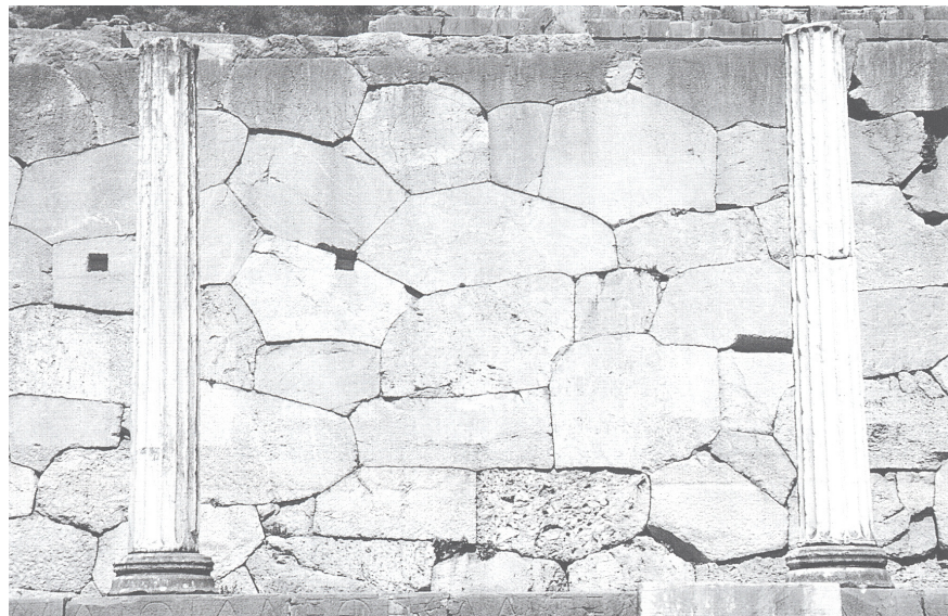
Columnas de la stoa de los Atenienses y muro poligonal de la plataforma del templo de Apolo de Delfos, ca. 470 a.C. y principios del siglo VI a.C. respectivamente
