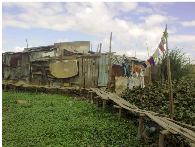
Les passerelles en bois permettent le passage d'une habitation à l'autre lorsque les plaines sont inondées
