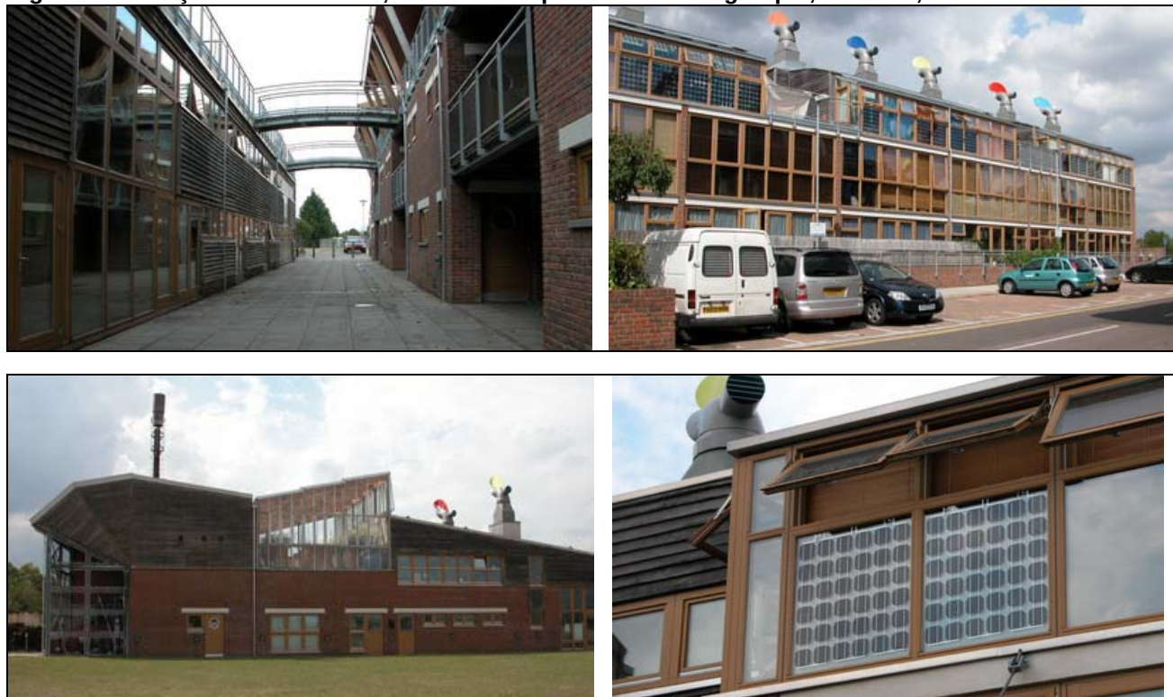
Figure 3.29: Façades nord et sud, éléments de production énergétique, BedZED, Londres
