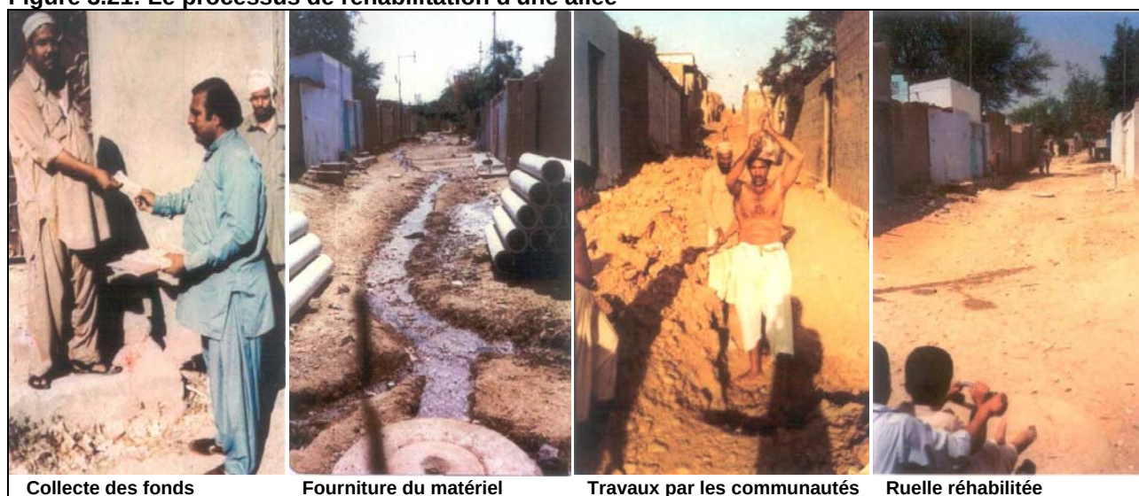
Figure 3.21: Le processus de réhabilitation d'une allée
