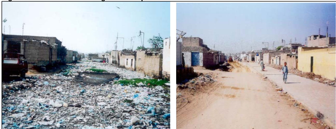
Figure 3.19: Une allée de Orangi avant et après réhabilitation
