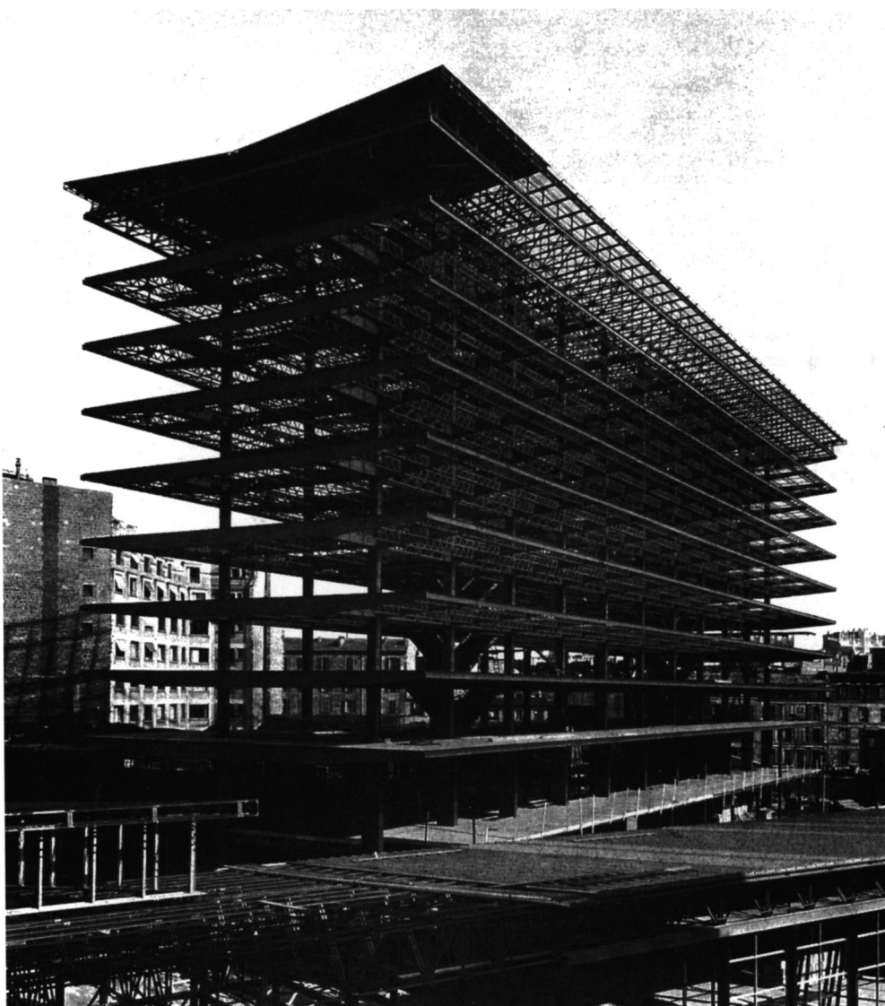
Figure 4. CAF, steel frame during erection, 1957. Caisse Centrale d'Allocations Familiales de la Région Parisienne, leaflet, 1959.
