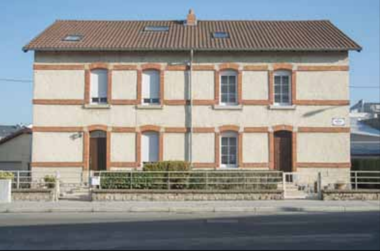
Rue de l'Acierie: Wurfassade und Ziegeleinlagen ermöglichen eine preiswerte Architektur.
