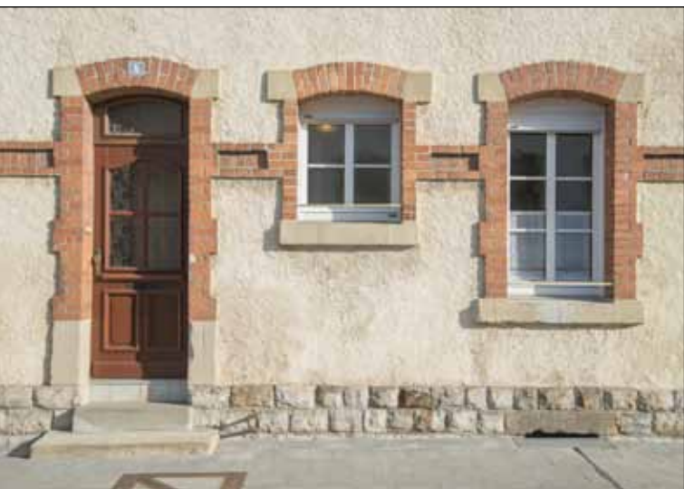
Rue de l'Acierie: Société Anonyme des Maisons Ouvrières
