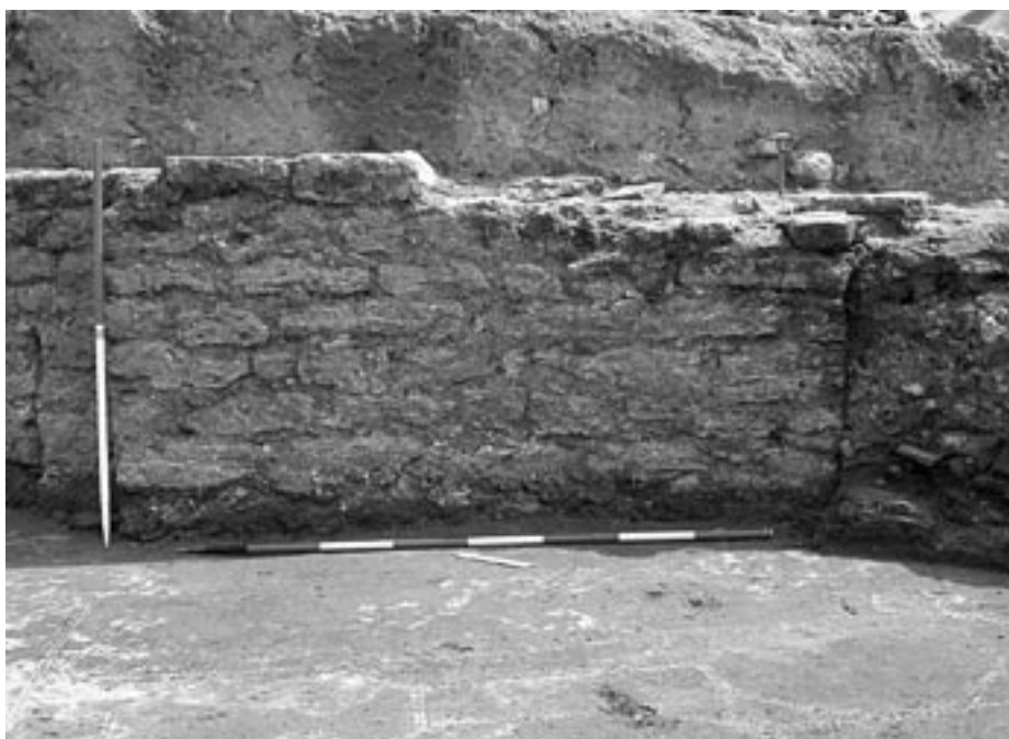
fig. 6 – Muro est dell'abside meridionale afferente alla 'sala triabsidata': dettaglio dell'opera muraria.
