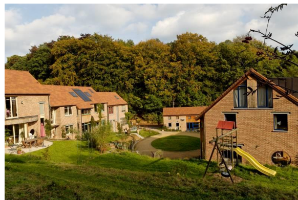
Figure 6. Square of cohousing « Bois del Terre » Coupez Office
