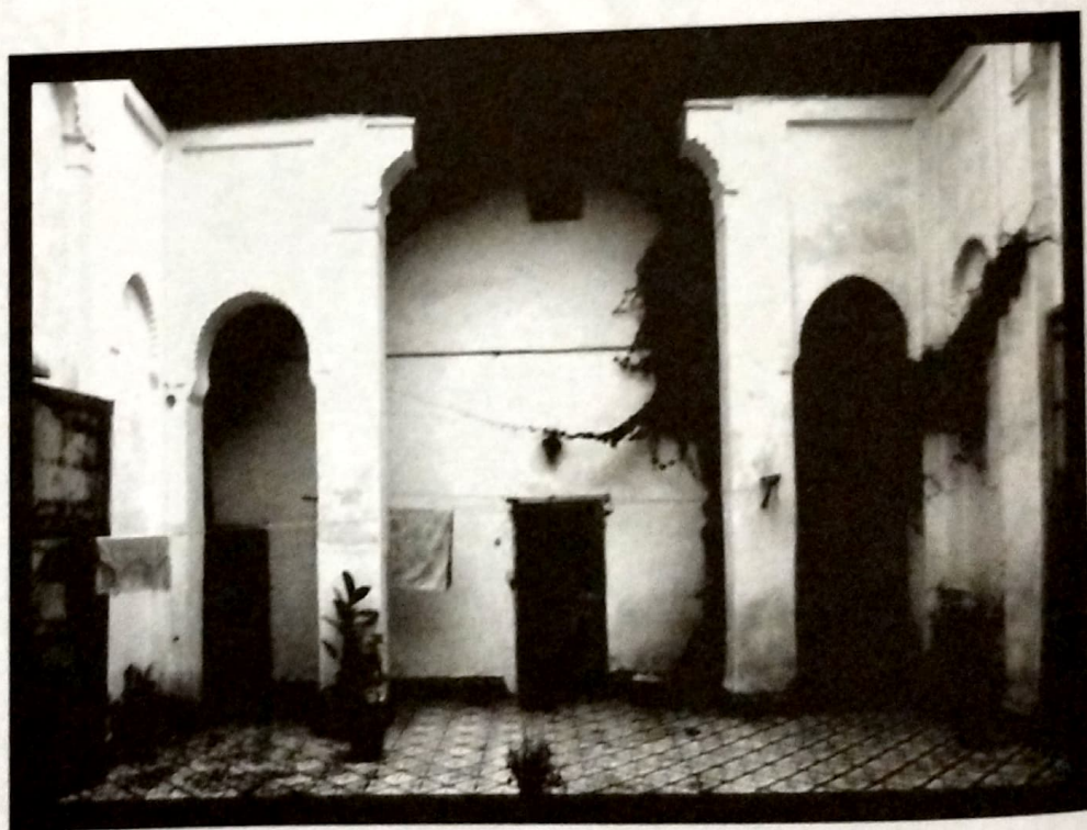
Maison qui aurait été celle de Sid Bou 'Amr. Vue intérieure du patio (1992). Ph Q. Wilbaux.
