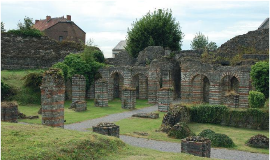
Les cryptoportiques du forum sont les parties les mieux conservées du monument. Ces galeries semi-enterrées soutenaient les portiques qui entouraient sur trois côtés la place de l'aire sacrée.
