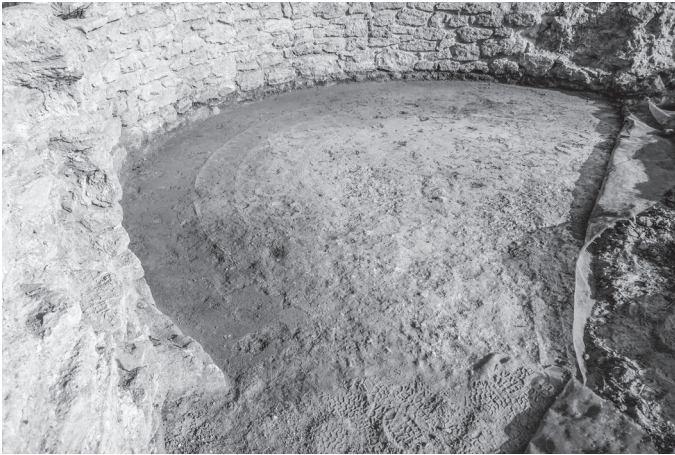
Fig. 5 – Stato di conservazione della porzione di pavimentazione restaurata prima dell'intervento (©UCLouvain).
