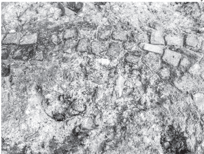
Fig. 1 – Stratigrafia del cementizio misto a base litico-fittile (©UCLouvain).
