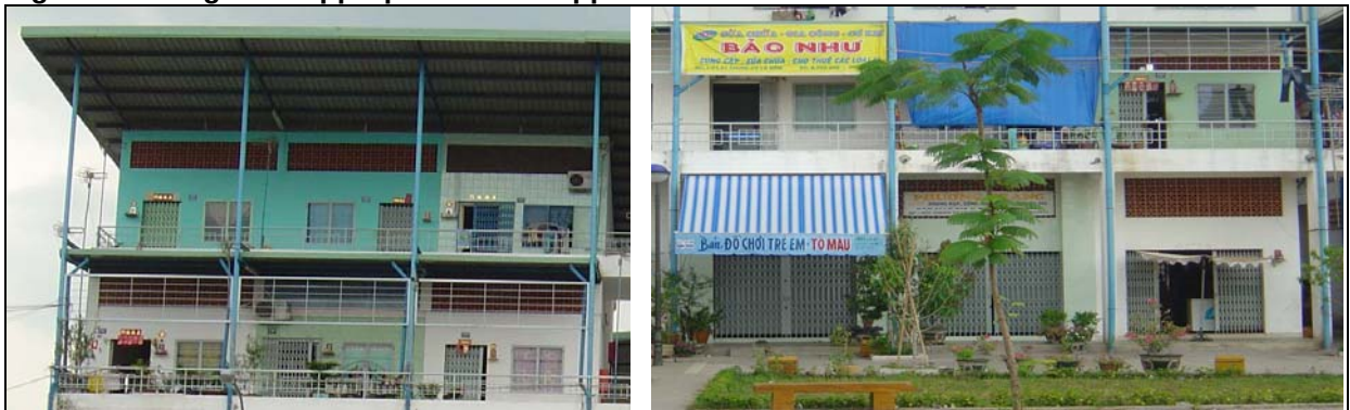
Façade repeinte et recarrelée par unité de logement
