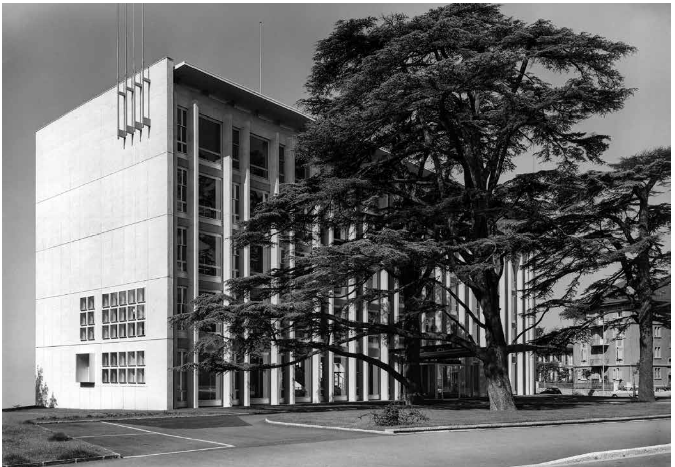
Un béton brut anobli, dont la précision l'assimile à la pierre calcaire : Jean Tschumi, siège de la Mutuelle Vaudoise Accident, Lausanne, 1951-1956 (ARCHIVES DE LA CONSTRUCTION MODERNE – EPFL. FONDS JEAN TSCHUMI. 0060.01.0098/09)
