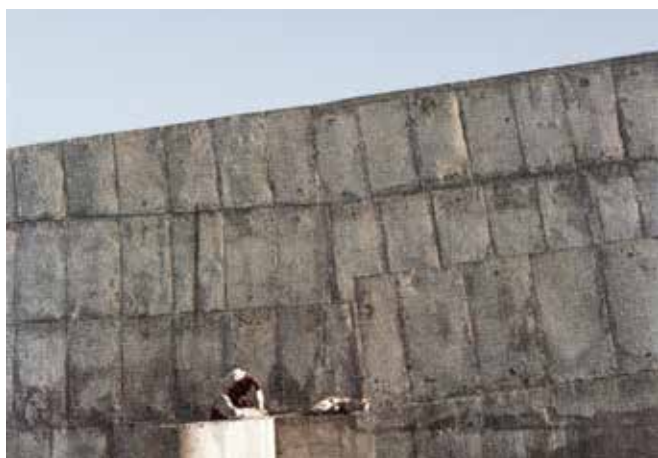
Dolf Schnebli, Secrétariat de Chandigarh (LC, 1953). Un exemple de béton brut, tel qu'il sort de coffrages métalliques (BULLETIN DU CIMENT, VOL. 28, 12.1960, P. 9)
