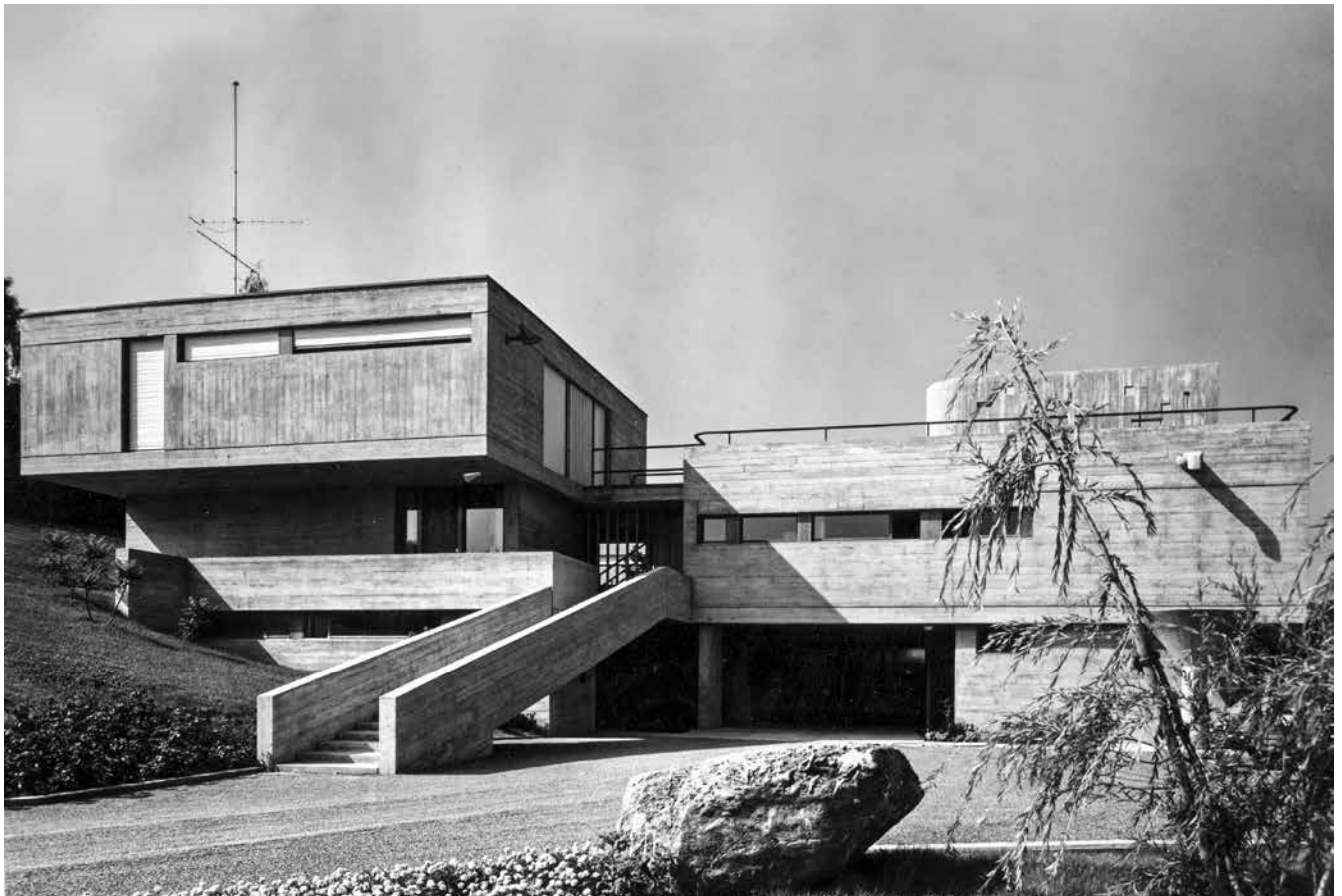
Georges Brera, villa Maier, Cologny (GE), 1958-1959 (KLEMM/ARCHIVES PRIVÉES DE L'ATELIER D'ARCHITECTURE BMS)
