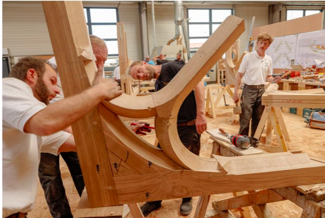
Des charpentiers vérifient les assemblages d'un des panneaux décorés des gradins
