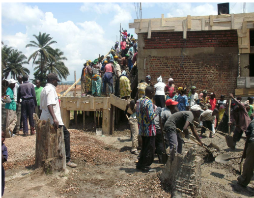
16. Mélange des matériaux au sol
