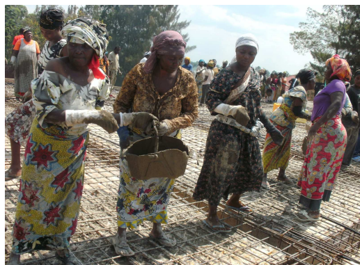
18. Femmes relayant le béton sur plancher
