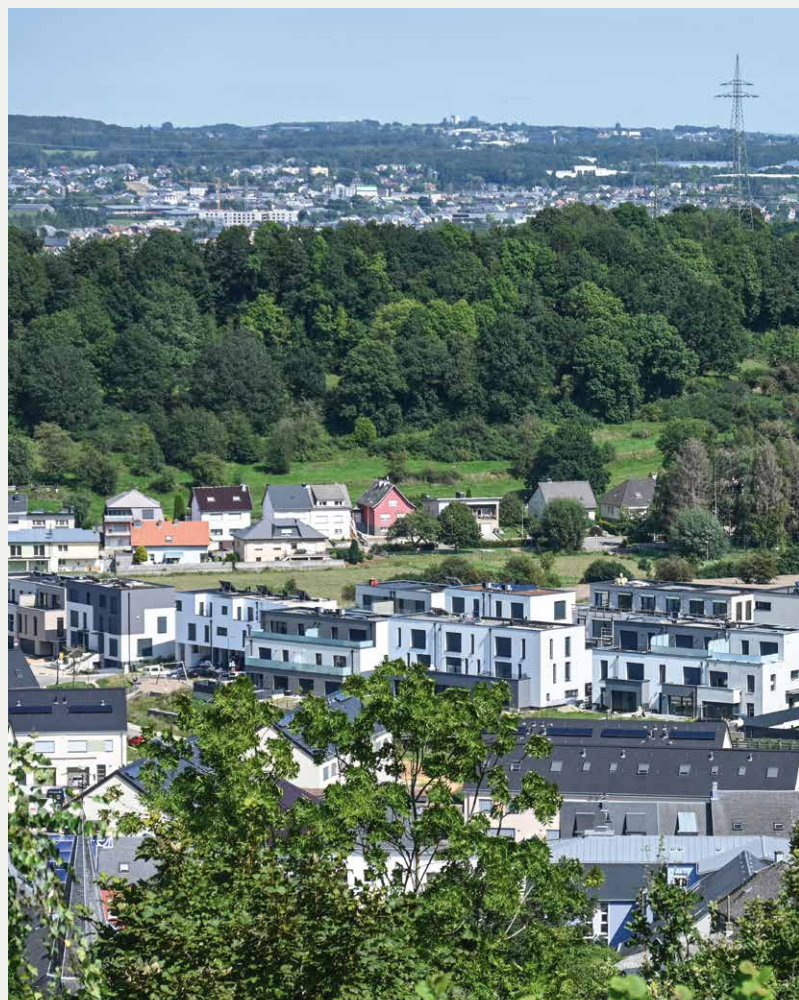
Logements "verts" à Pétange (Luxembourg)
