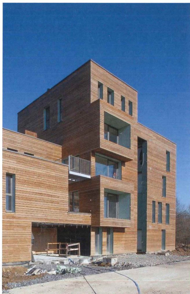
■ Maison multifamilial Les Closières, Mont-sur-Marchienne, Baneton-Garrino Architectes et Lamcol, 2016.
