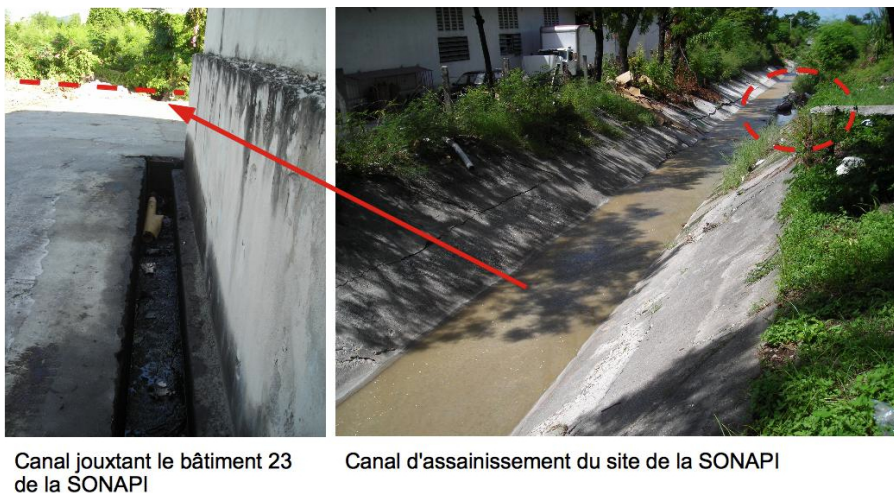
FIGURE 6.1 – Canal d'évacuation des eaux usées traversant le site du parc industriel de la SONAPI
