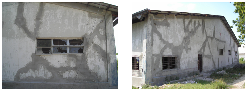
FIGURE 3.1 – Types de dégâts observés sur les bâtiments de la SONAPI
