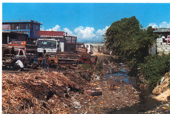
FIGURE 6.5 – Conséquences de l'inadéquation du réseau d'assainissement de l'actuel Port-au-Prince [64]
