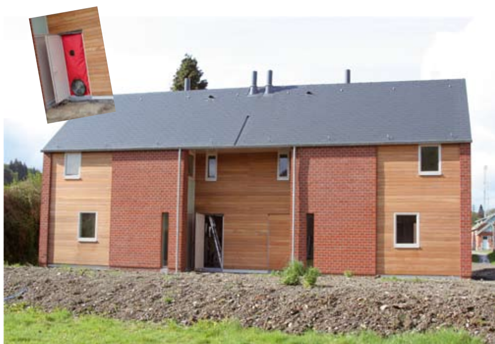
Test d'étanchéité à l'air. Photo : © SPW – J.-C. Carpentier
