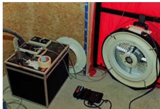
Test d'étanchéité à l'air. © SPW – J.-C. Carpentier
