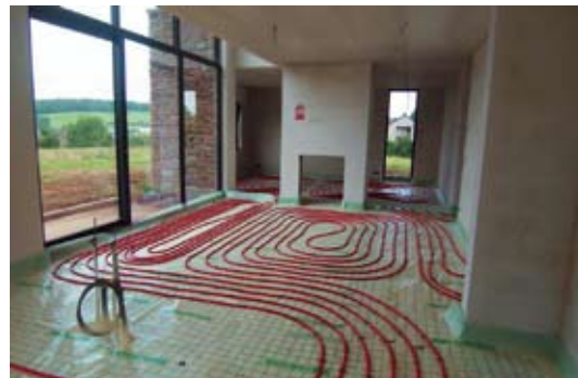
Photo : © Atelier Grondal
