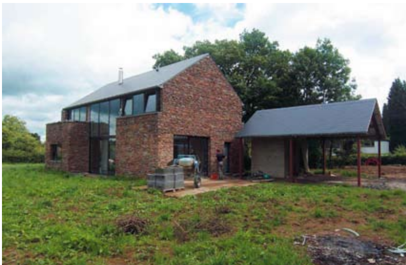
Photo : © Atelier Grondal
