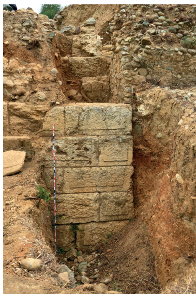
Fig. 3. Angle nord-est de la tour hellénistique. En haut à dr., l'enceinte romaine en opus caementium butant contre la partie épiercée du flanc nord de la tour (© P. Fontaine)
