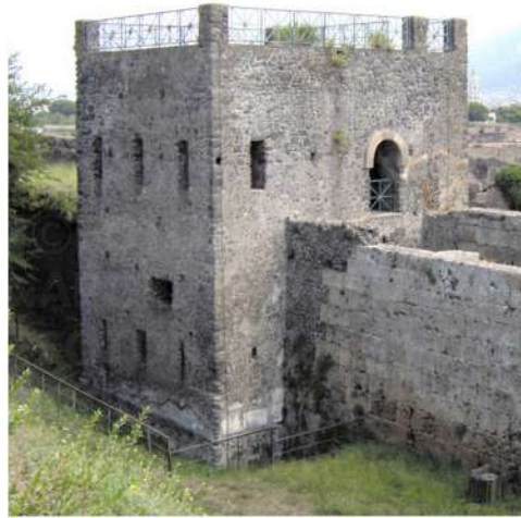
Fig. 3. Pompéi. Tour XI de l'enceinte, près de la Porta Vesuvio. Maçonnerie à parement en opus incertum (vers 100 av. J.-C.)
