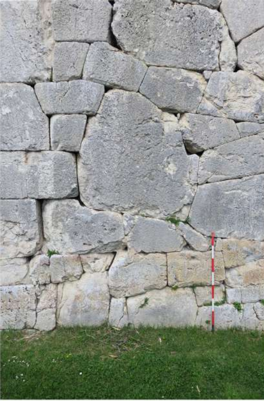
Fig. 8. Amelia. Détail de l'appareil polygonal sur l'éperon sud de l'enceinte. Le grand bloc central compte jusqu'à quinze petits et grands côtés (III-II e s. av. J.-C.)
