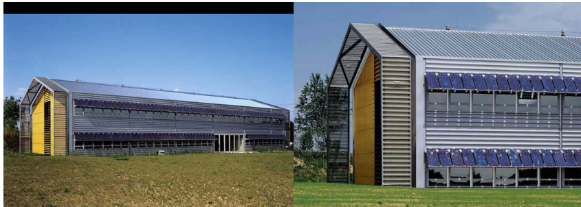
Bureau Total, J. Ferrier, La Tour de Salvagny, France – Panneaux solaires.
