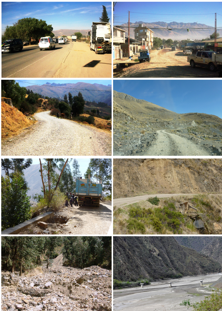
Imagen 15. Fotografías de materiales, carriles y obras complementarias en el Tramo Vinto-Sacambaya (F-25)
