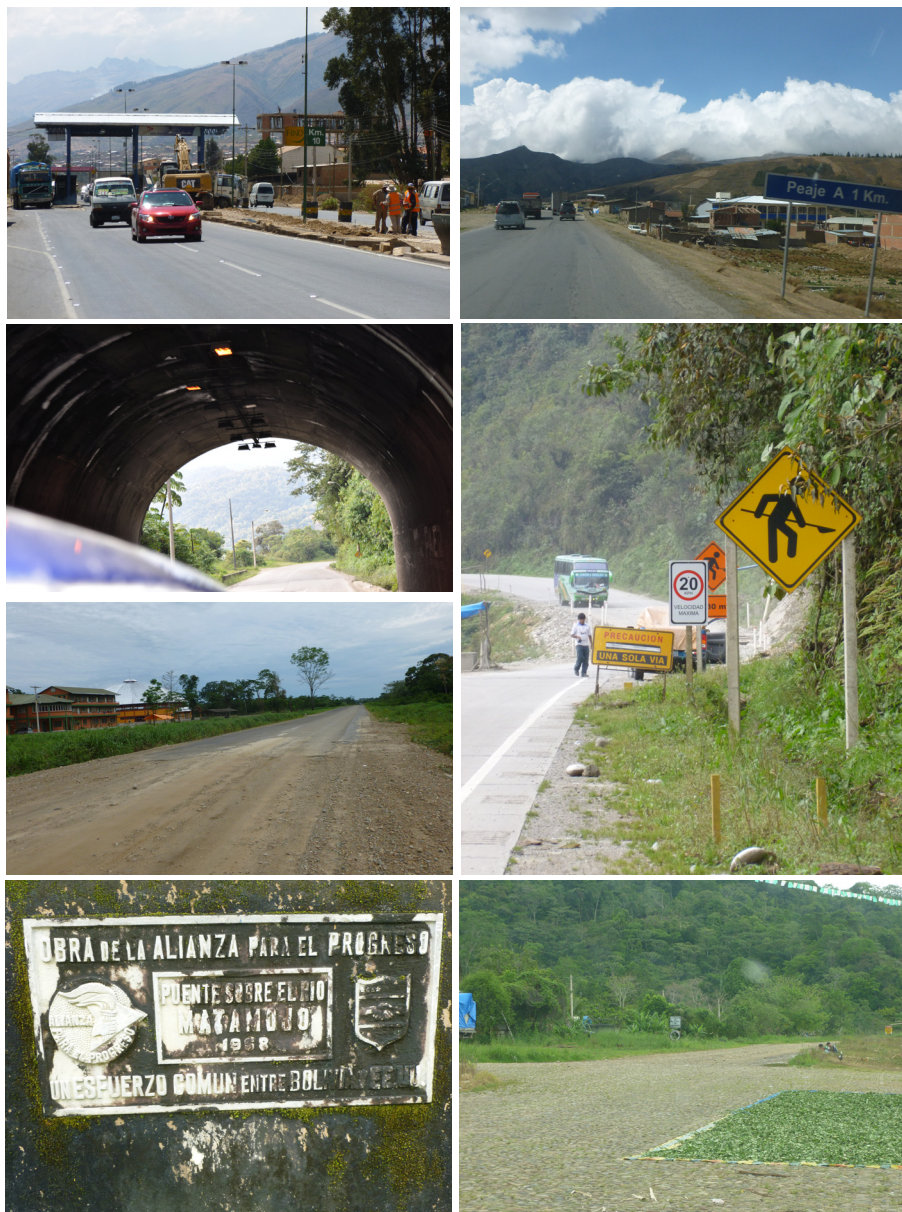
Imagen 16. Fotografías de materiales, carriles y obras entre el Área Metropolitana de Cochabamba, Villa Tunari (F-4) e Isinuta (F-24),
