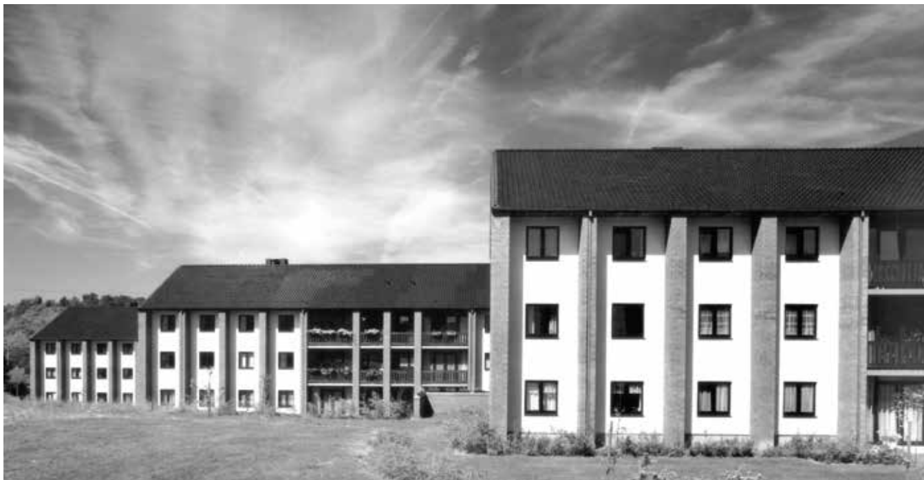
↑ Cité de la Corolle, Ougrée, 1996. © Dethier Architecture
