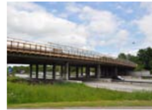
Pont-dalle Copenhague - Danemark
