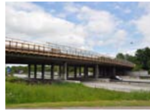
Pont-dalle Copenhague - Danemark
