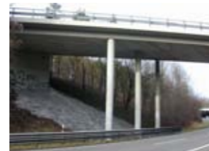
Pont-dalle Genève (A1) - Suisse
