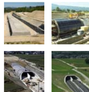
Phases constructives de la tranchée couverte de la Beuchille, Suisse
