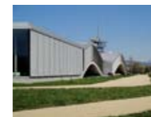
Façade sud : perception d'arcs
