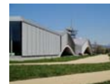
Façade sud : perception d'arcs
