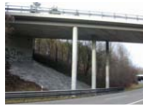
Pont-dalle Genève (A1) - Suisse
