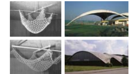
Maquettes utilisées par Isler pour déterminer la forme de ses coques.
