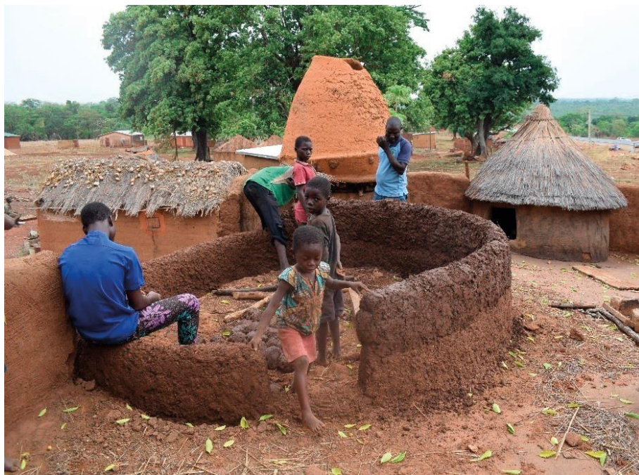
Figure 27 : Construction d'une case supplémentaire à l'étage.
