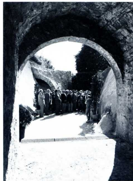
Vue perspective de la brèche pratiquée dans la profondeur d'un bastion pour assurer le désenclavement de la forteresse (Photo P. Dandoy).
